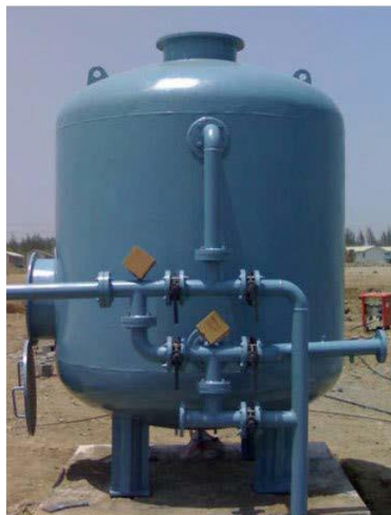
სურათი 5.1. ქვიშისფილტრი
