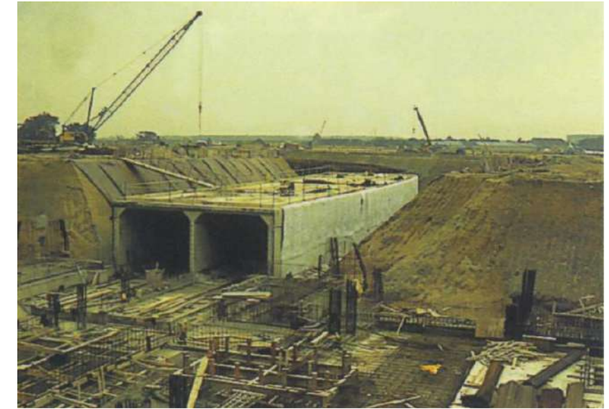
ილ. 17. გვირაბის მშენებლობა სტენსედის აეროპორტში (ლონდონი, დიდი ბრიტანეთი). წყარო: პონომარიოვი ა.ბ., ვინიკოვი იუ.ლ. მიწისქვეშა მშენებლობა. 2014.
