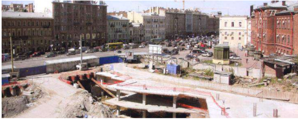
ილ. 15. მიწისქვეშა პარკინგის მშენებლობა სანკტ-პეტერბურგში. წყარო: პონომარიოვი ა.ბ., ვინიკოვი იუ.ლ. მიწისქვეშა მშენებლობა. 2014.
