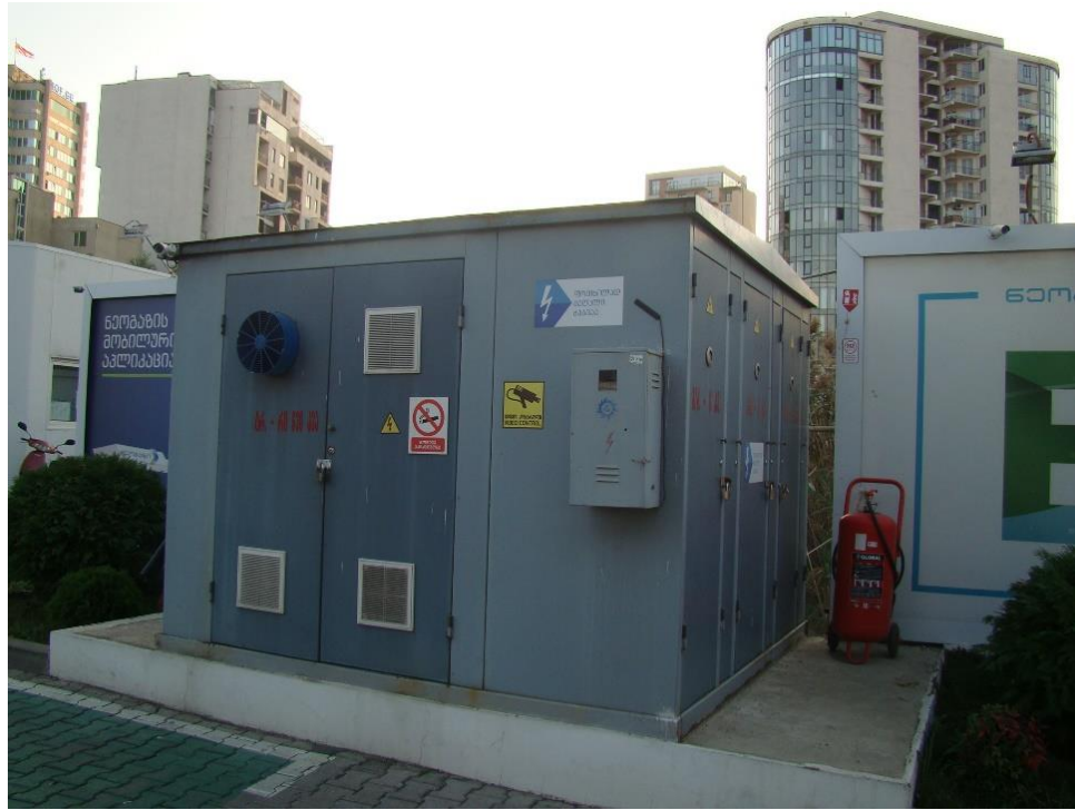
სურ. N 9 - ელექტროენერჯის სატრანსფორმატორო ჯიხური
