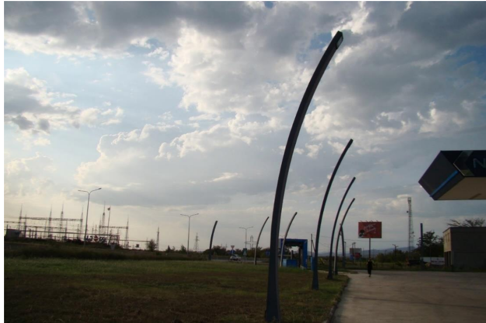
სურ. N13 - ობიექტის ტერიტორიაზე არსებული განათება
