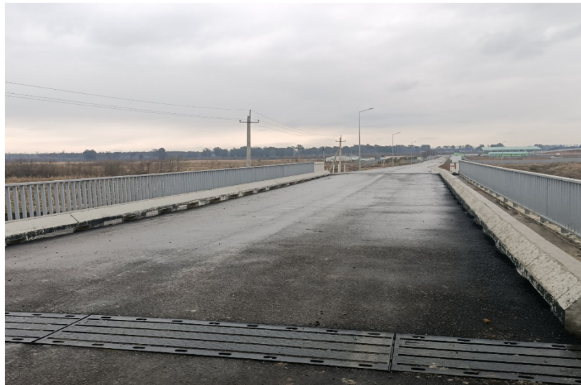
სურათი 11.0 - ახალ ნაგავსაყრელზე მისასვლელი გზა
