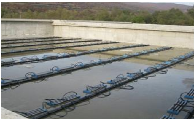
სურ. 4.3.2 - მარცხენა: ამენებული აუზის ნიმუში დიფუზორის სისტემით. მარჯვენა - აერატორი სარემონტო მდგომარეობაში (ნიმუში)
