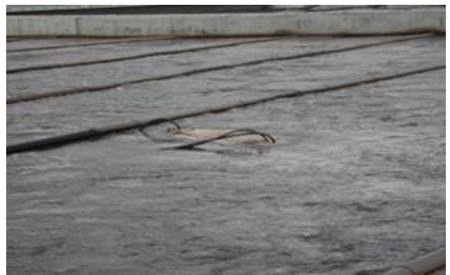
სურ. 4.3.2 - მარცხენა: ამენებული აუზის ნიმუში დიფუზორის სისტემით. მარჯვენა - აერატორი სარემონტო მდგომარეობაში (ნიმუში)
