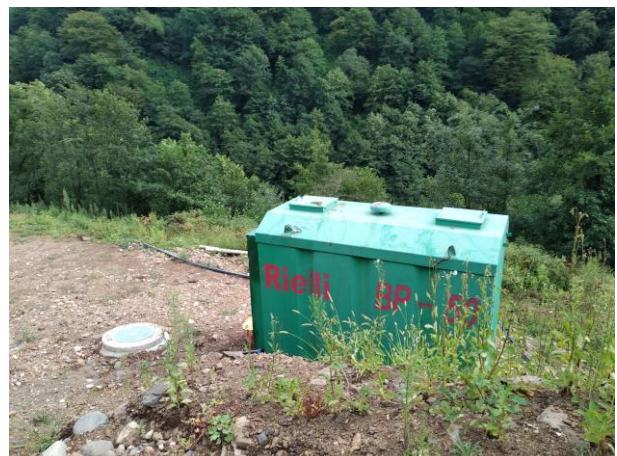
სურათი 2.1.2. ხობი 2 ჰესის სამშენებლო ბანაკის არსებული ბიოლოგიური გამწმენდი ნაგებობა
