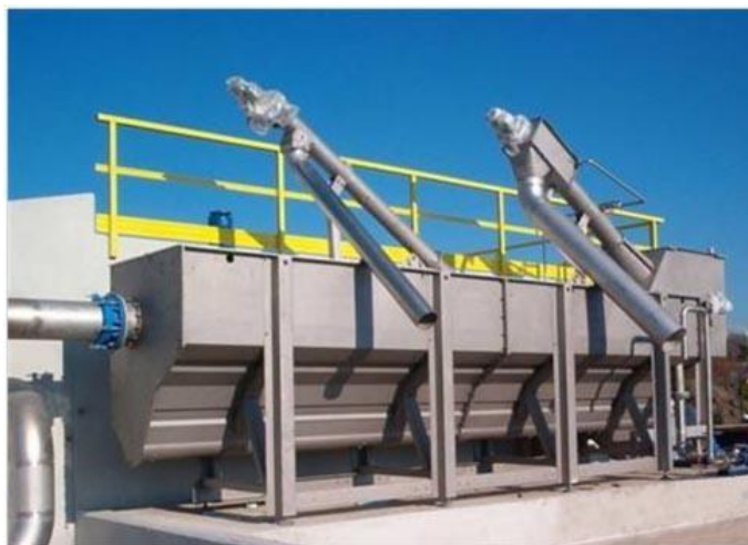
სურ. 7 - ტიპური კომბინირებული ცხაურის/ქვიშა/ცხიმის მოცილება
