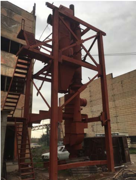
სურათი 3.3. ვენტური-სკრუბერი
