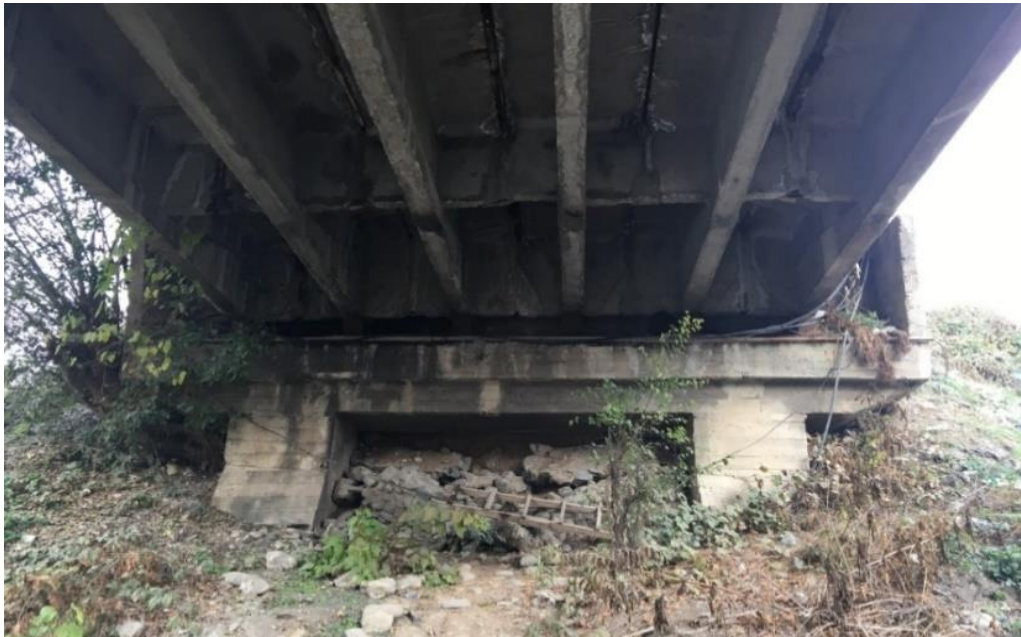
სურათი 1-6: არსებული ხიდის ამორტიზებული სტრუქტურა
