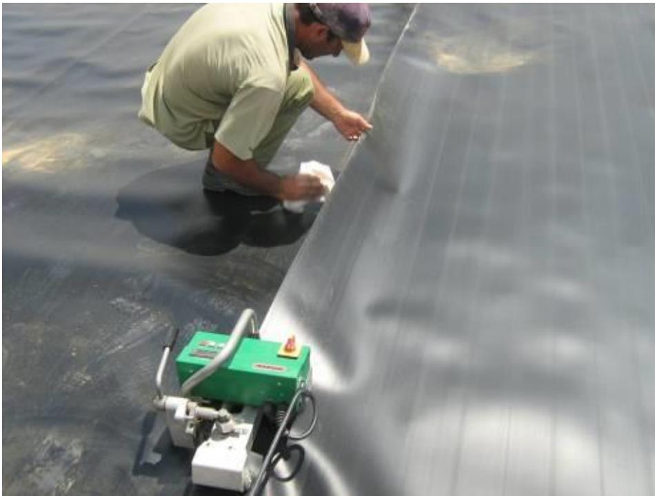
სურათი 2.3.2.4. შეკავშირების ნაკერების შემოწმება: ნაკერებს შორის ჩაიტუმბება ჰაერი, თუ მანომეტრში 10 წუთის განმავლობაში წნევა არ დაეცა, მაშინ ნაკერი ითვლება საიმედოდ
