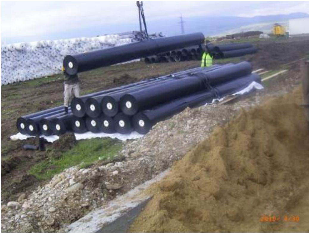
სურათი 2.3.2.2. გომემბრანის დაფენა უჯრედში: ჩანს ქვიშით სავსე ტომრები გომემბრანის ქარისაგან დასაცავად მანამდე, სანამ არ მოხდება მემბრანის კიდეების შეკავშირება სპეციალური აპარატით
