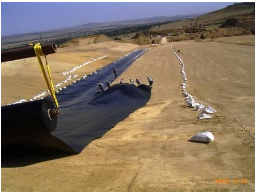
სურათი 2.3.2.2. გომემბრანის დაფენა უჯრედში: ჩანს ქვიშით სავსე ტომრები გომემბრანის ქარისაგან დასაცავად მანამდე, სანამ არ მოხდება მემბრანის კიდეების შეკავშირება სპეციალური აპარატით
