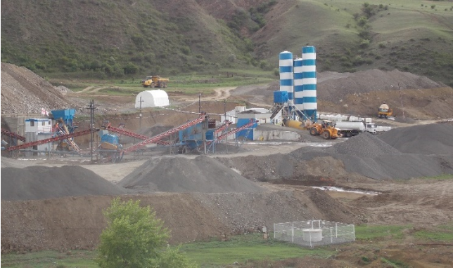
ბეტონის კვანძი და ინერტული მასალების სამსხვრევ-დამხარისხებელი საამქრო
