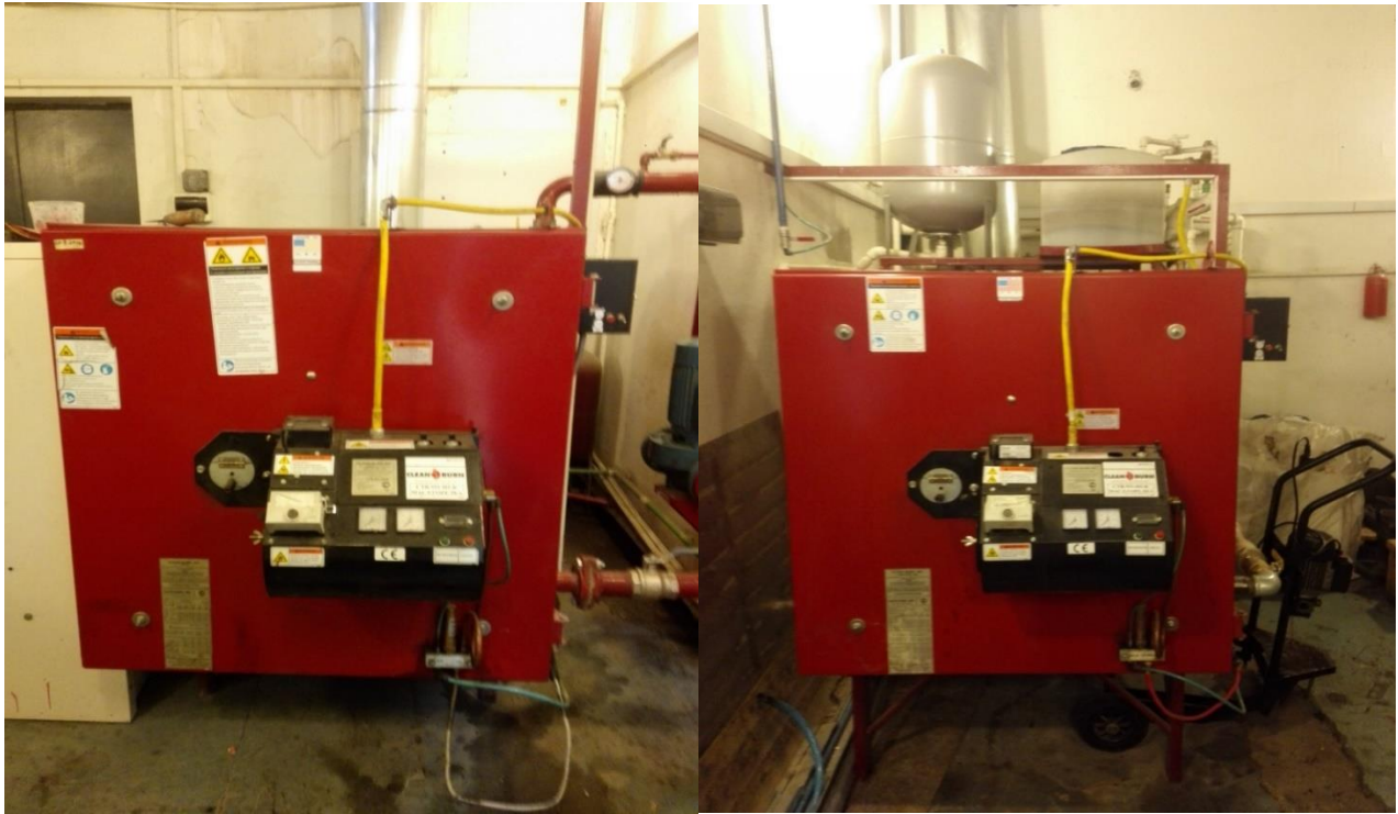
სურ.№3 - ობიექტზე განთავსებული „CLEAR BURN“-ის მოდელის წყალგამათბობელი
